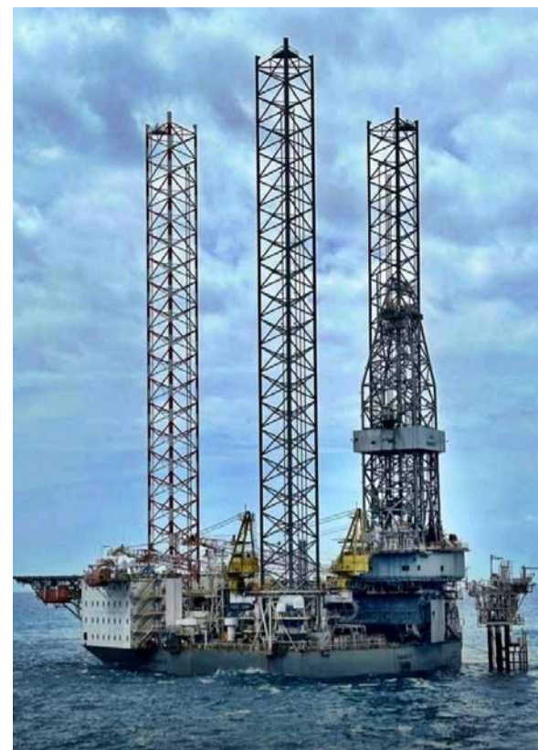
Plataforma auto elevatória PA-39 junto à plataforma PGA-8
